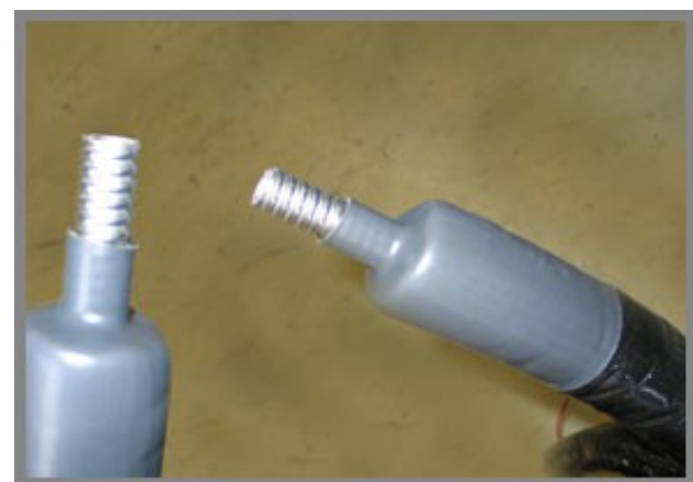
Schrumpfschlauch angepasst
